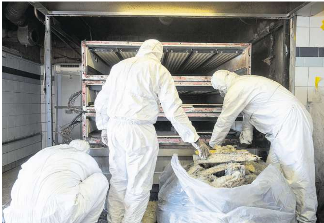
Drei Arbeiter bauen seit gestern Morgen den alten Backofen aus.
