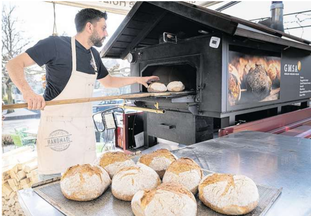
Fabian Füger demonstriert den Holzofen, der während der Bauarbeiten in der Backstube als Ersatz dient.
